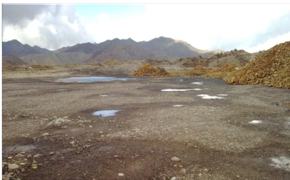
شکل 9. باقی ماندن آب باران پس از گذشت 24 ساعت از پایان بارندگی روی کومه 31 معدن سرچشمه، آذر 1390
