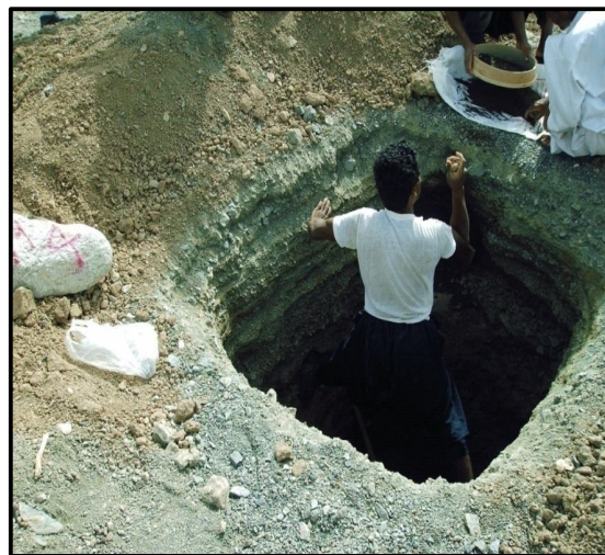
شکل 6. تصویری از یک چاهک حفر شده (TP-04) در ناحیه دره جوگز بالا در منطقه فنوج و لایه‌های ماسه سیاه فوقانی آن.
