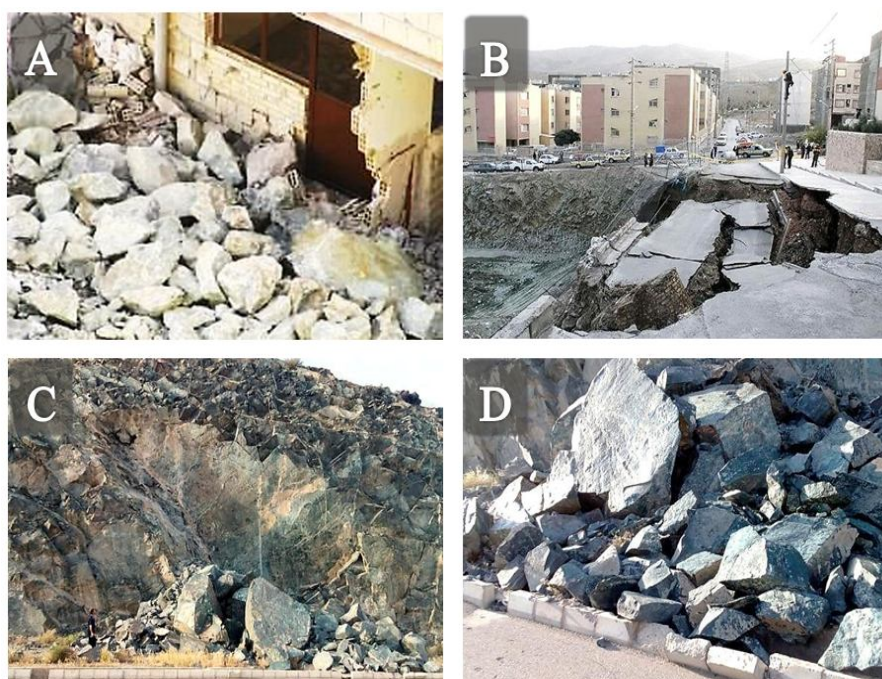
شکل ۱۳. مشکلات مربوط به سنگ‌های اولترامافیک منطقه، A: ناپایداری دامنه، B: ریزش گود، C و D: لغزش سنگ‌ها (جنوب‌غرب مشهد)
